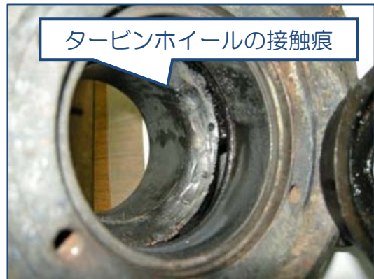
写真 33 タービンハウジング内部
