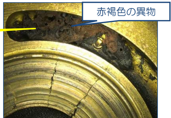
写真 39 溝部分の異物
