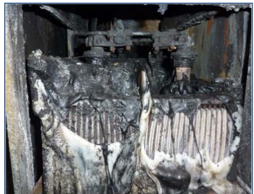
写真14 バッテリー及び端子
