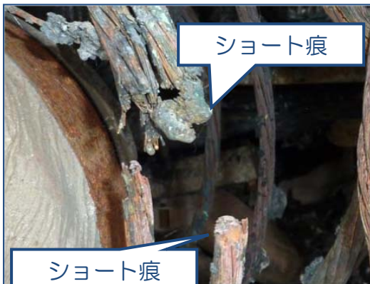
写真13 オルタネータ配線
