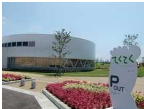
写真 1：子育ての駅外観（長岡市提供）
