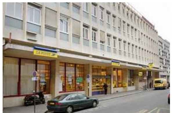
写真 2：改装し新たに店舗を誘致した建物（SEMAEST）
