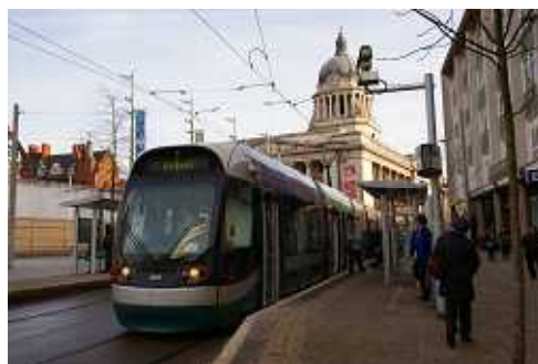
写真 2：中心部の LRT 停留所。歩道から直接乗り込める。
