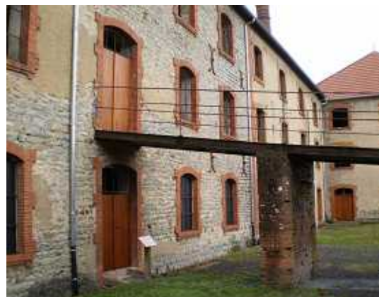
写真 3: 旧レンガ工場の未修復部分
