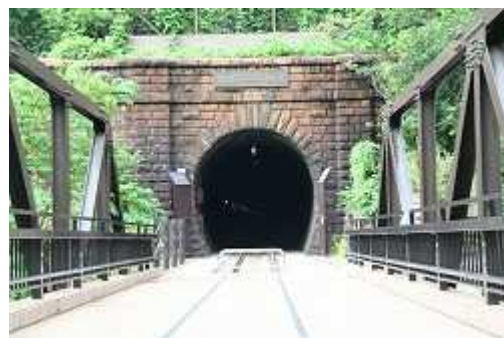
写真 3：大日影トンネル遊歩道入口
