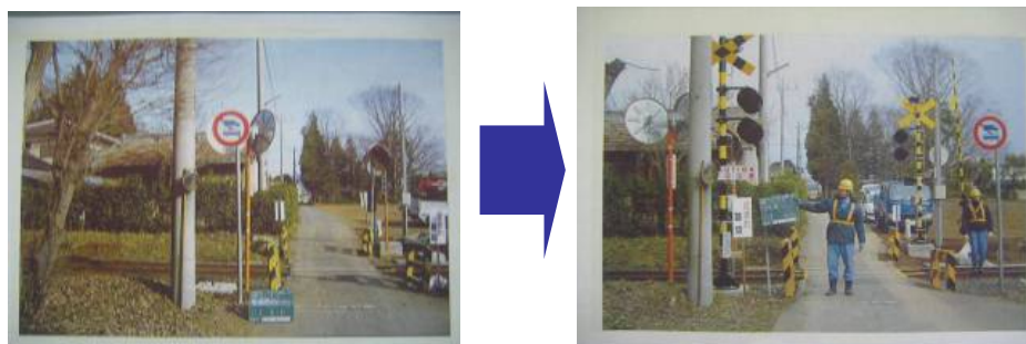
図1:踏切遮断機・警報機の整備
