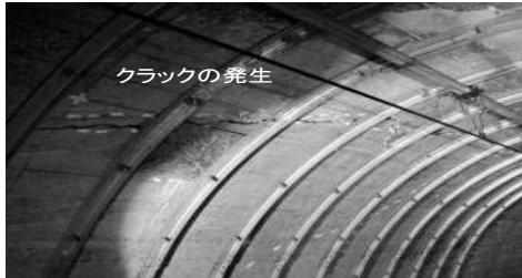
トンネル(改修前)
