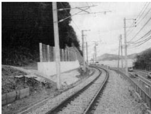
【落石防止擁壁の一例】
