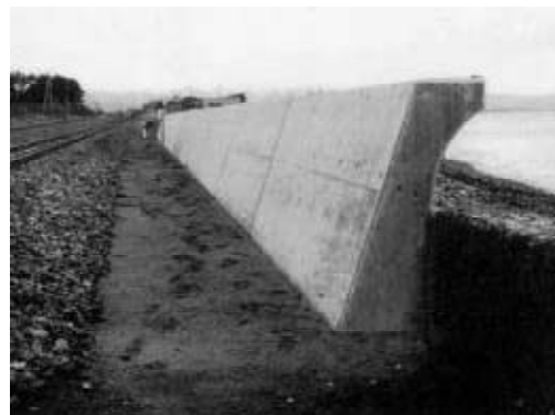
【護岸壁の一例】
