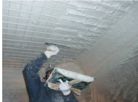
▲ 増厚工法による補強
