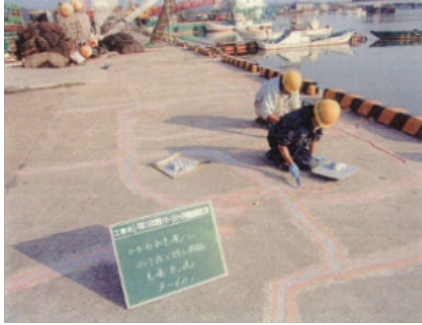
▲ エプロンのひび割れに樹脂を充填
