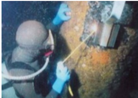
▲ 水中溶接による電気防食の施工
