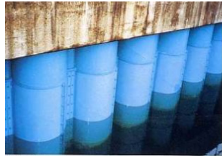
▲ 劣化した鋼管杭を補強
