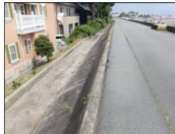
住居等に近接する老朽化した堤防
