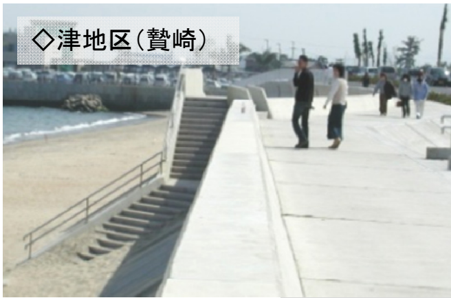
▲砂浜に通じる階段を備えた海岸堤防
