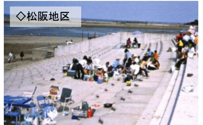
▲砂浜へのアクセスが容易な階段護岸
