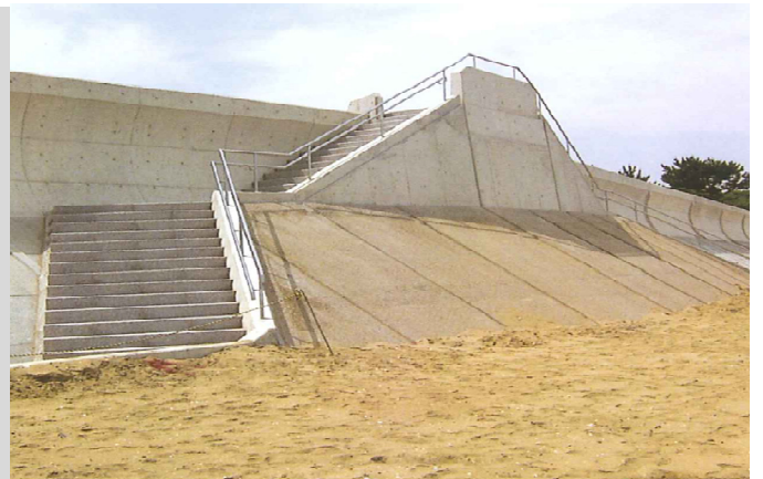
▲砂浜から見た海岸堤防
