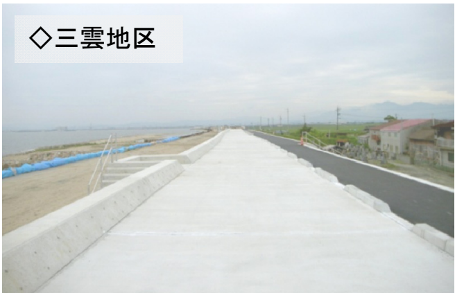
▲通路を併設した海岸堤防
