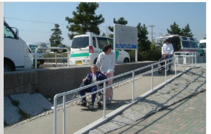
▲スロープを備えた海岸堤防
