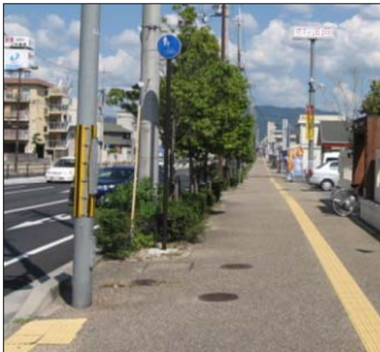
奈良市地区 国道308号 (奈良県奈良市)
