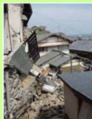
○多くの家屋が損壊被害
