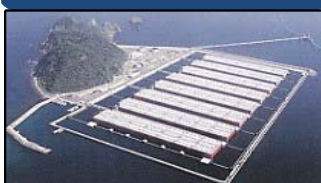
浮体式石油備蓄基地（ベトナム）
