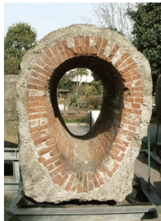
明治14年に着工したレンガ製下水道(横浜市)
