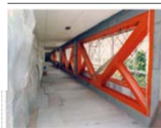
鉄骨ブレースによる壁の補強
