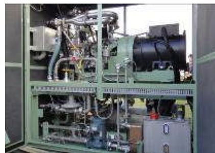
消化ガス発電
