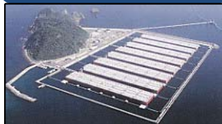
浮体式石油備蓄基地（ベトナム）
