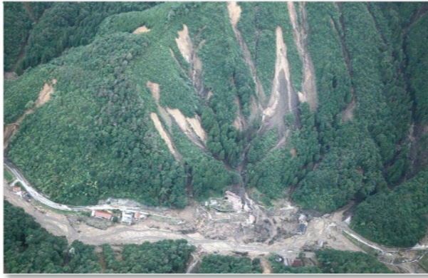
写真－7 庄原市の土砂災害
