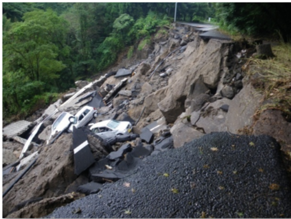
写真－1 主要地方道都城隼人線 (鹿児島県霧島市)
