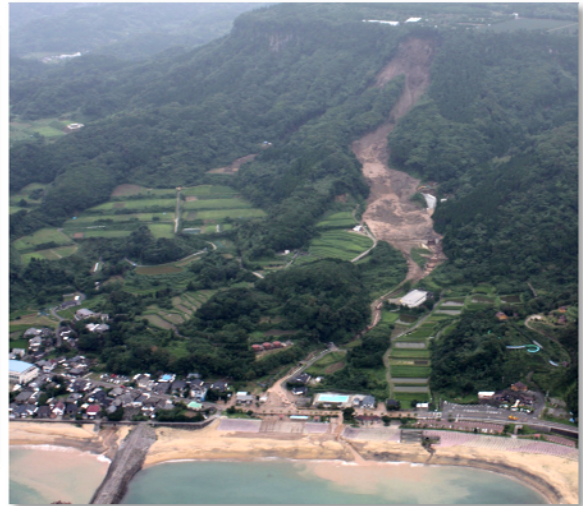
写真－2 鹿児島県南大隅町の土石流
