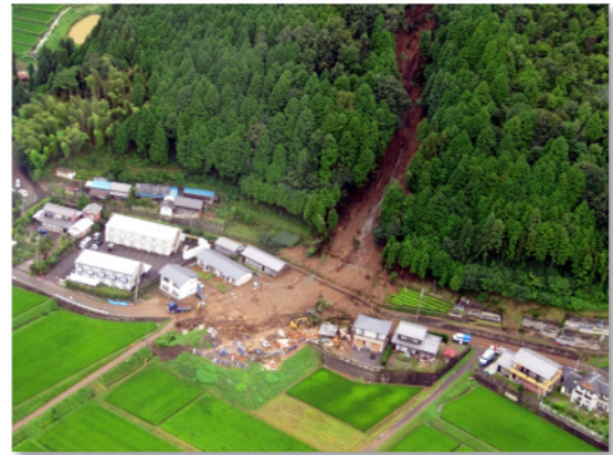
写真－6 八百津町の土石流
