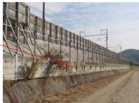
①脱線そのものを防止する対策 + ②脱線後の逸脱を防止する対策
