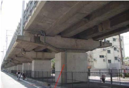
鉄筋コンクリートにより補強
