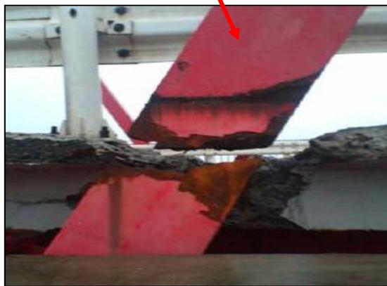
腐食で破断 2007年6月にトラス橋の斜材が破断
