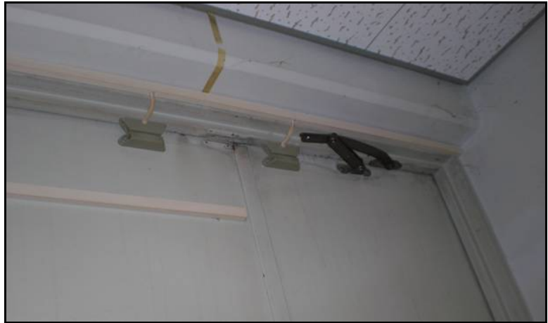
〈防火戸の閉鎖順位調整器の撤去〉
