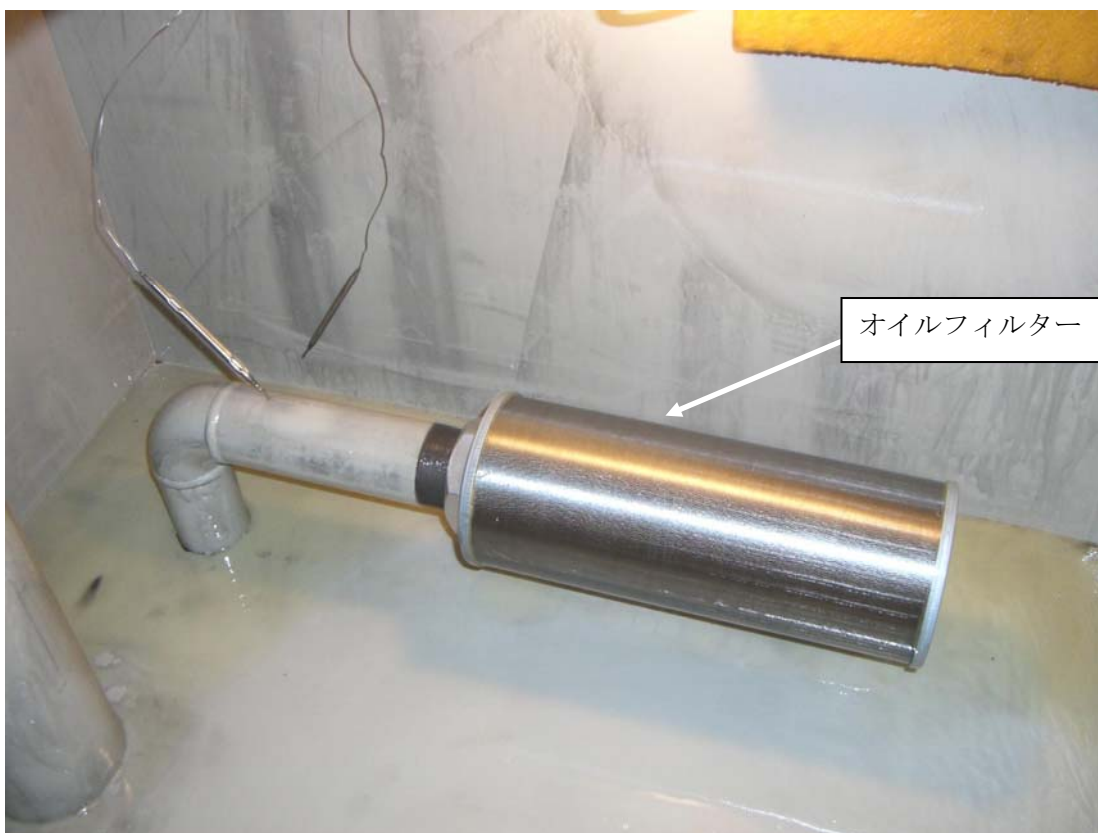
写真9 オイルタンク内（清掃前）
