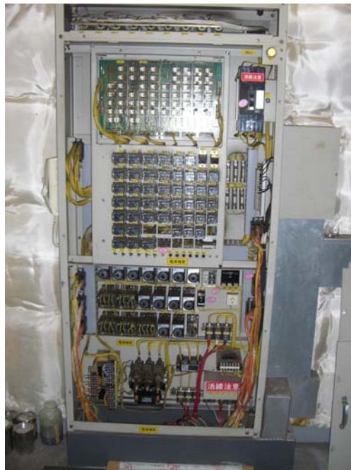
写真7 制御盤 (リレー方式)
