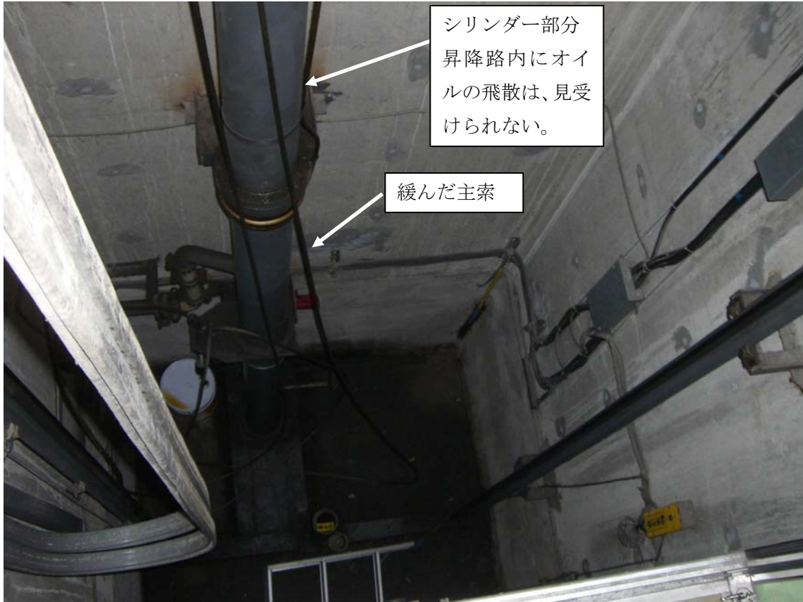
写真2 かごより下側の昇降路及びピット
