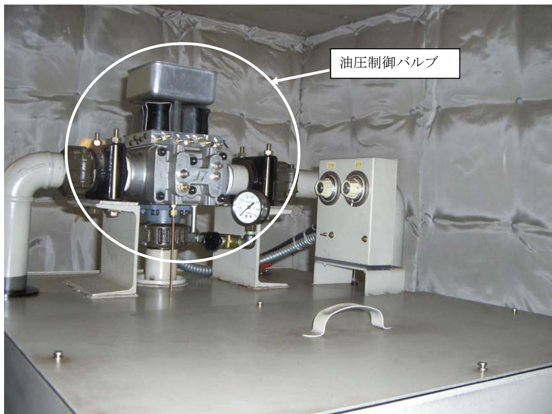
写真5 オイルタンク上の油圧制御バルブ
