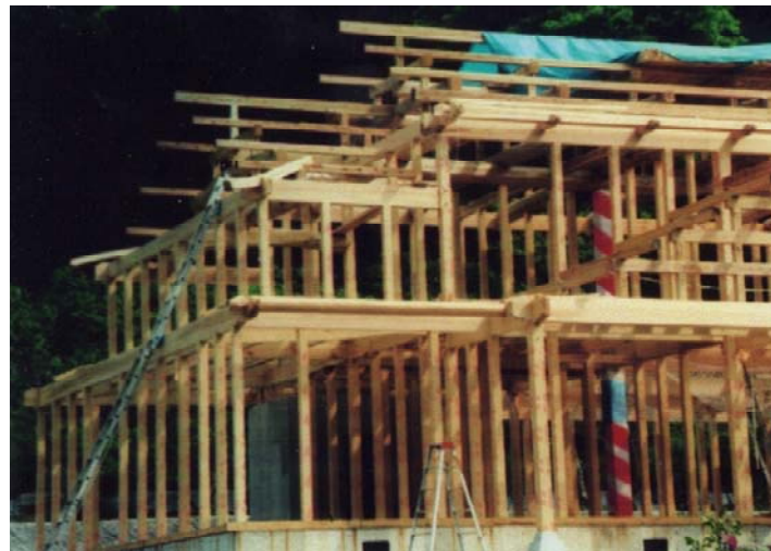
「柱角」製品を多用する「在来工法」住宅
