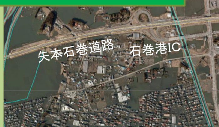
三陸縦貫道(矢本石巻道路)
