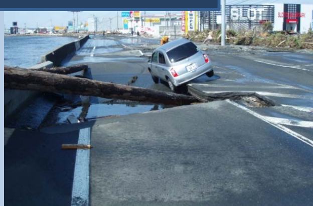
国道45号(石巻市)
