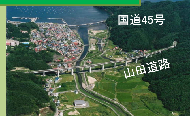
三陸縦貫道(山田道路)
