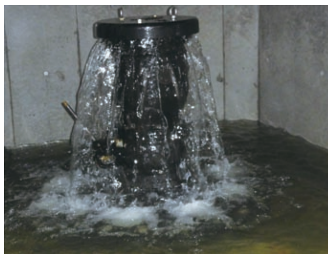
管路に設けられた空気弁の破損による漏水 (空気弁：管路中の空気を自動的に排出する装置)
