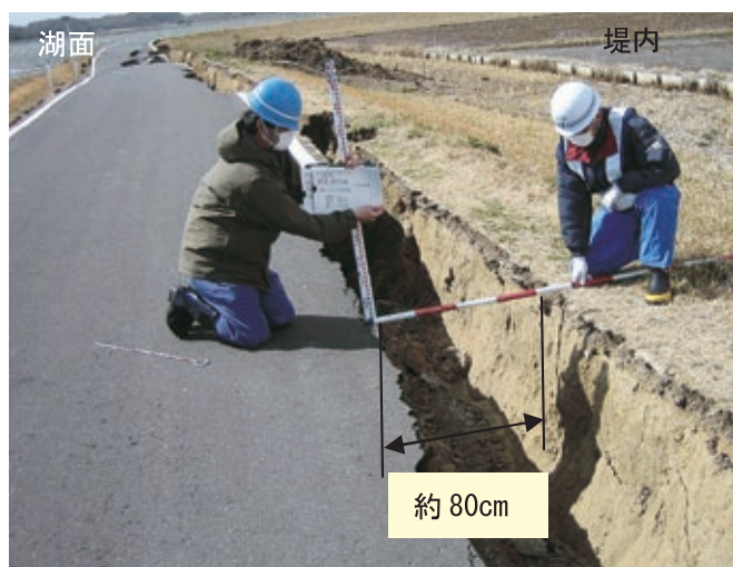
霞ヶ浦の堤防舗装境界部分で発生した亀裂
