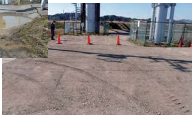
施設周辺の沈下は埋め戻して応急復旧（成田用水施設）
