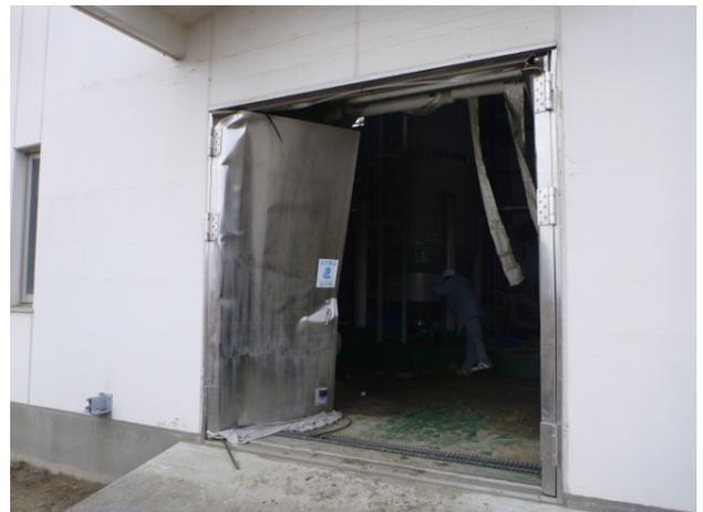
津波により破壊されたドア
