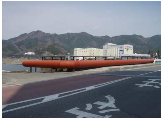
水管橋の仮設配管設置
