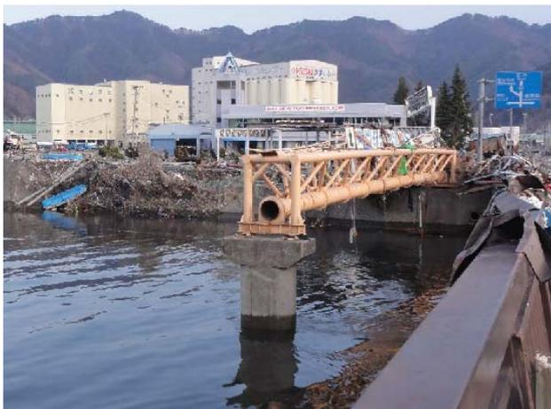
損壊した水管橋
