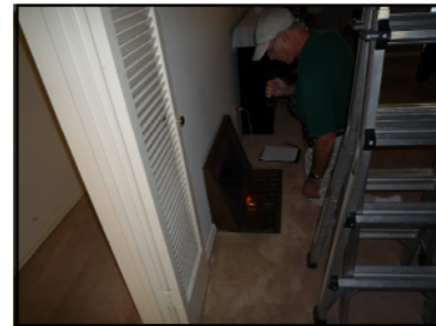
建物内部（室内）調査
