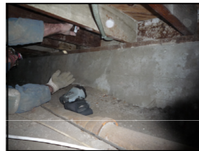
建物内部（床下）調査
