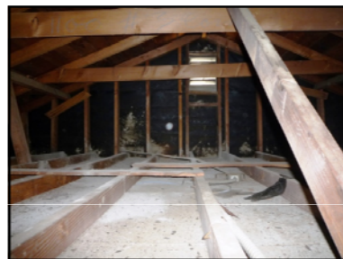
建物内部（屋根裏）調査
