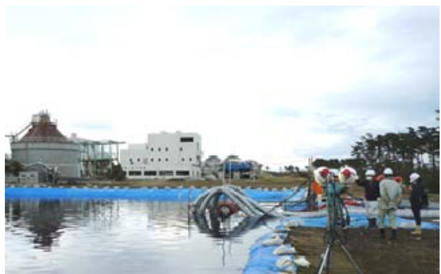
宮城県南浄化センター簡易処理放流状況の確認
