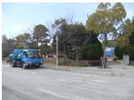
災害用トイレとバキュームカー
