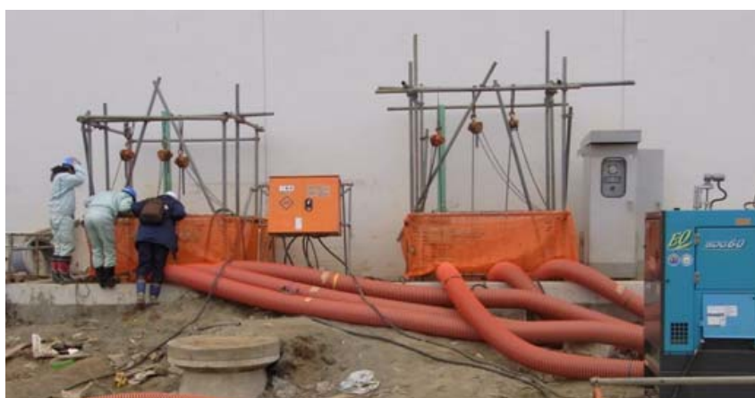
流入渠からの仮設ポンプによる汚水くみ上げ （宮城県石巻東部浄化センター）
