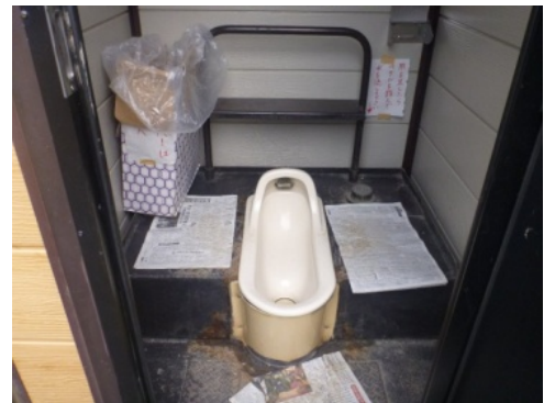
災害用仮設トイレ内(高田一中) (詰り防止のため紙は分別回収)
