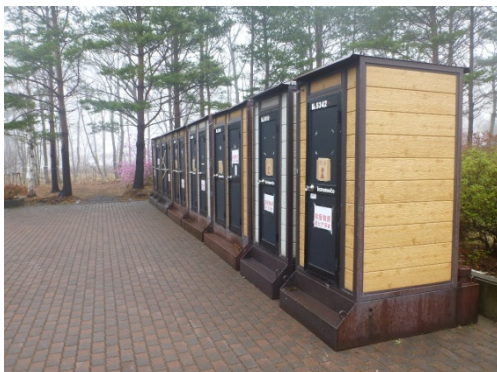
災害用仮設トイレの設置状況 (グリーンピア三陸宮古(アリーナ))
