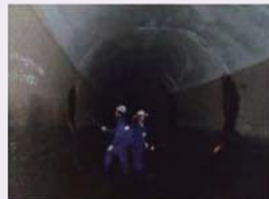
阿讃トンネル内部
