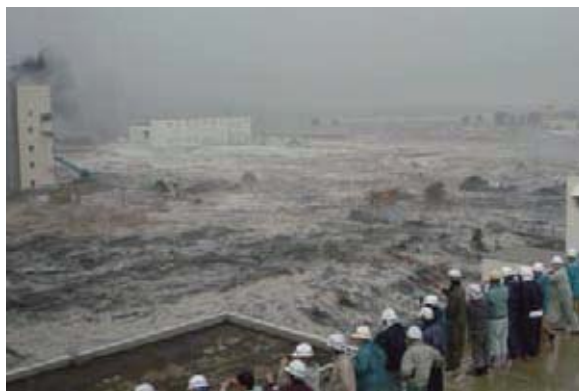
津波により浸水する下水処理場（仙台市南蒲生浄化センター） （出典）国土交通省下水道部資料
