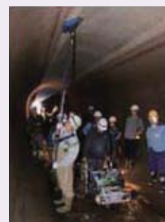
背面空洞調査(レーダー)の様子と調査イメージ図
