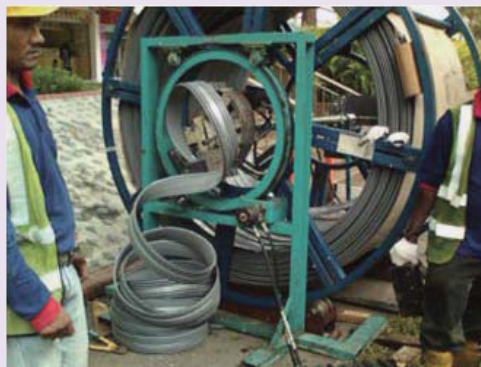
更生工法の一例
