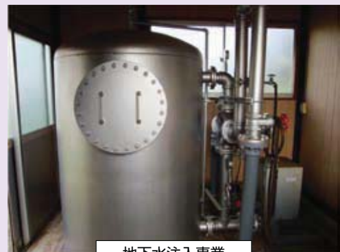
地下水注入事業
