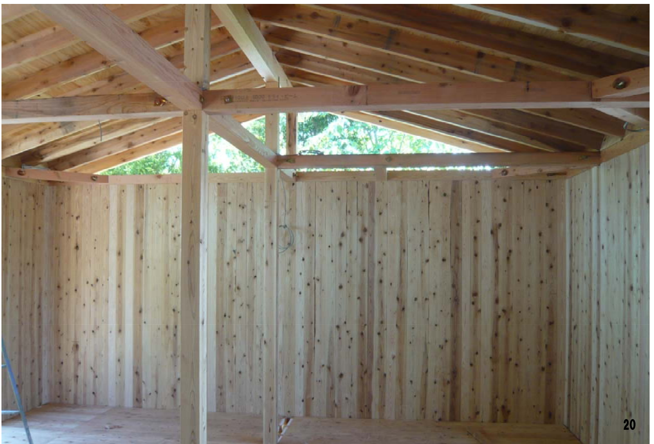
5、住棟端部室内壁
