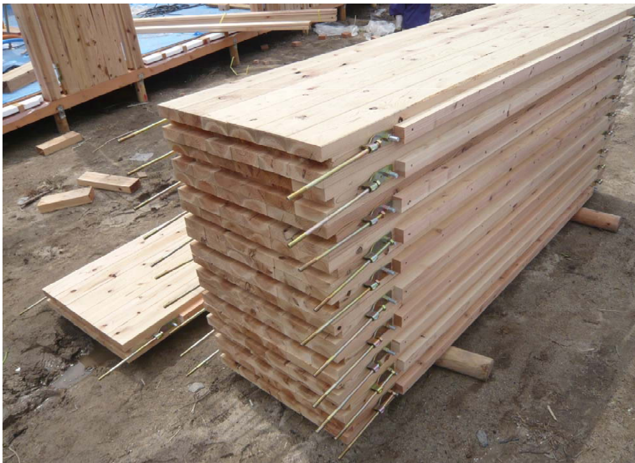
建て込まれるパネル
