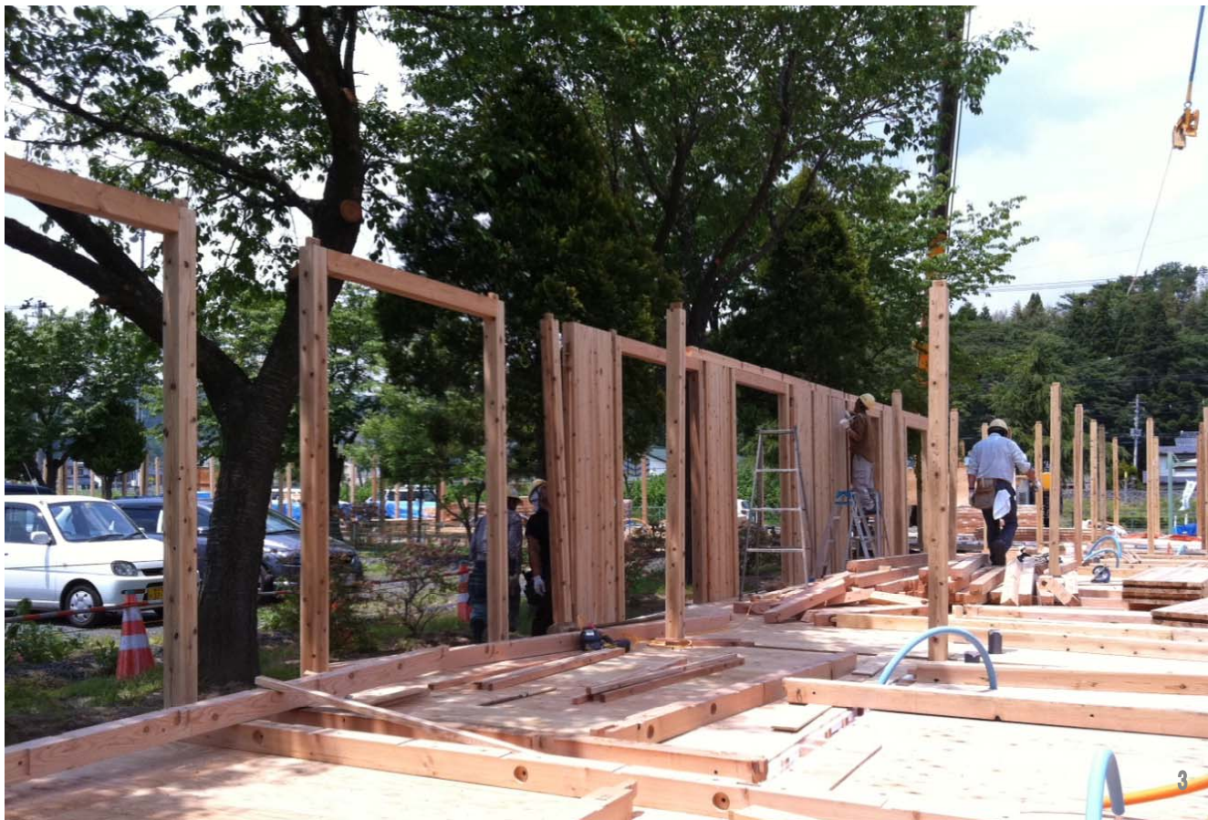
床パネルを設置後柱を立て込んでいる風景
