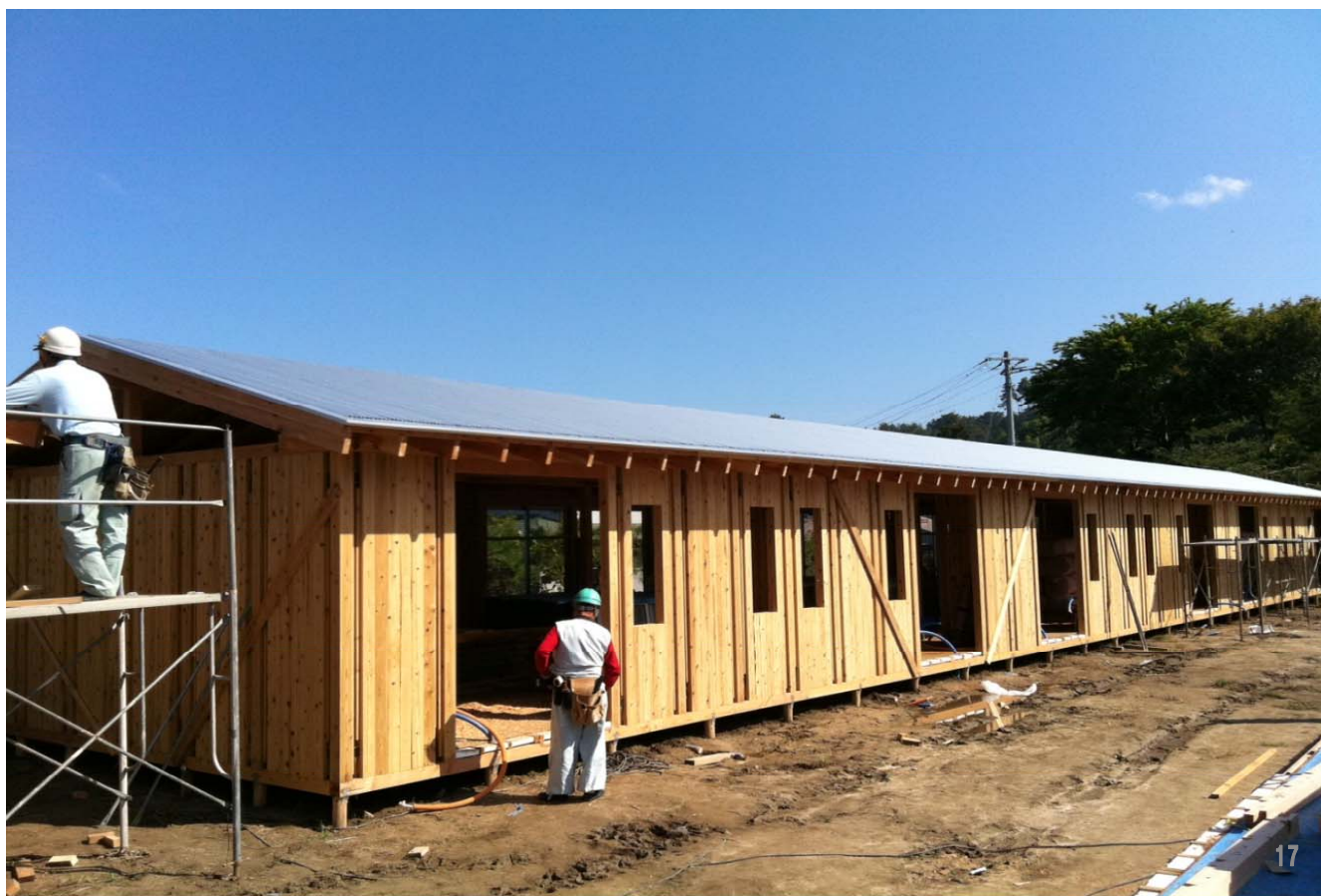
仕上がった屋根の様子
