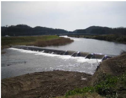
軽海用水頭首工
