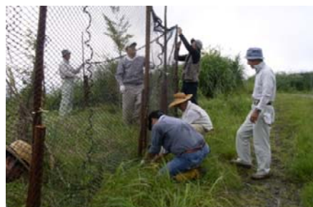
鹿食害防護柵の設置
