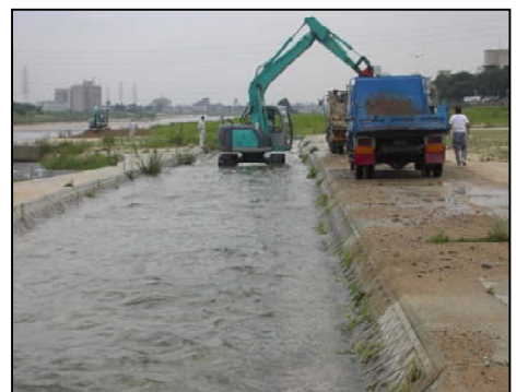
現在の浚渫作業
