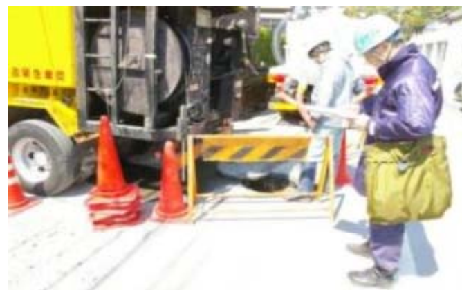
管路の被害状況の調査、清掃作業を行う職員
