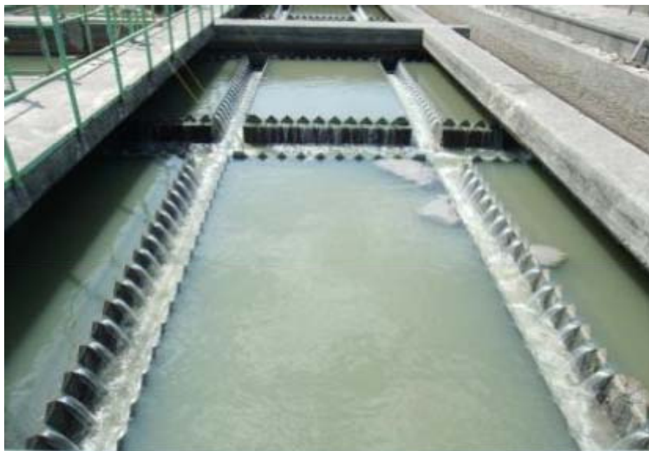
仙台市南蒲生浄化センター
