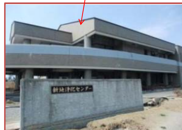
新地浄化センター
