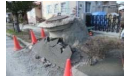
液状化により隆起したマンホール (千葉県浦安市)
