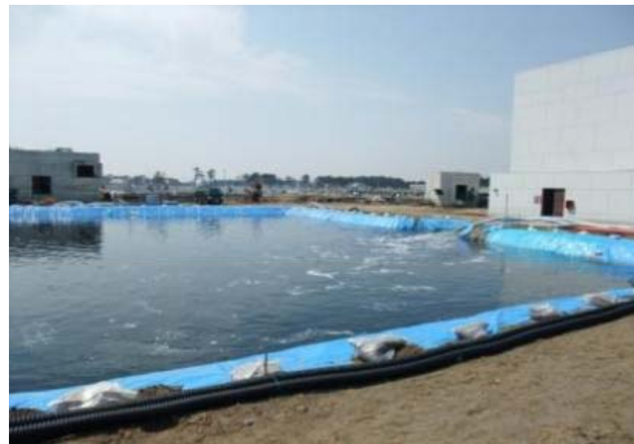
宮城県県南浄化センター
