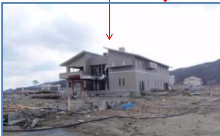
陸前高田浄化センター
