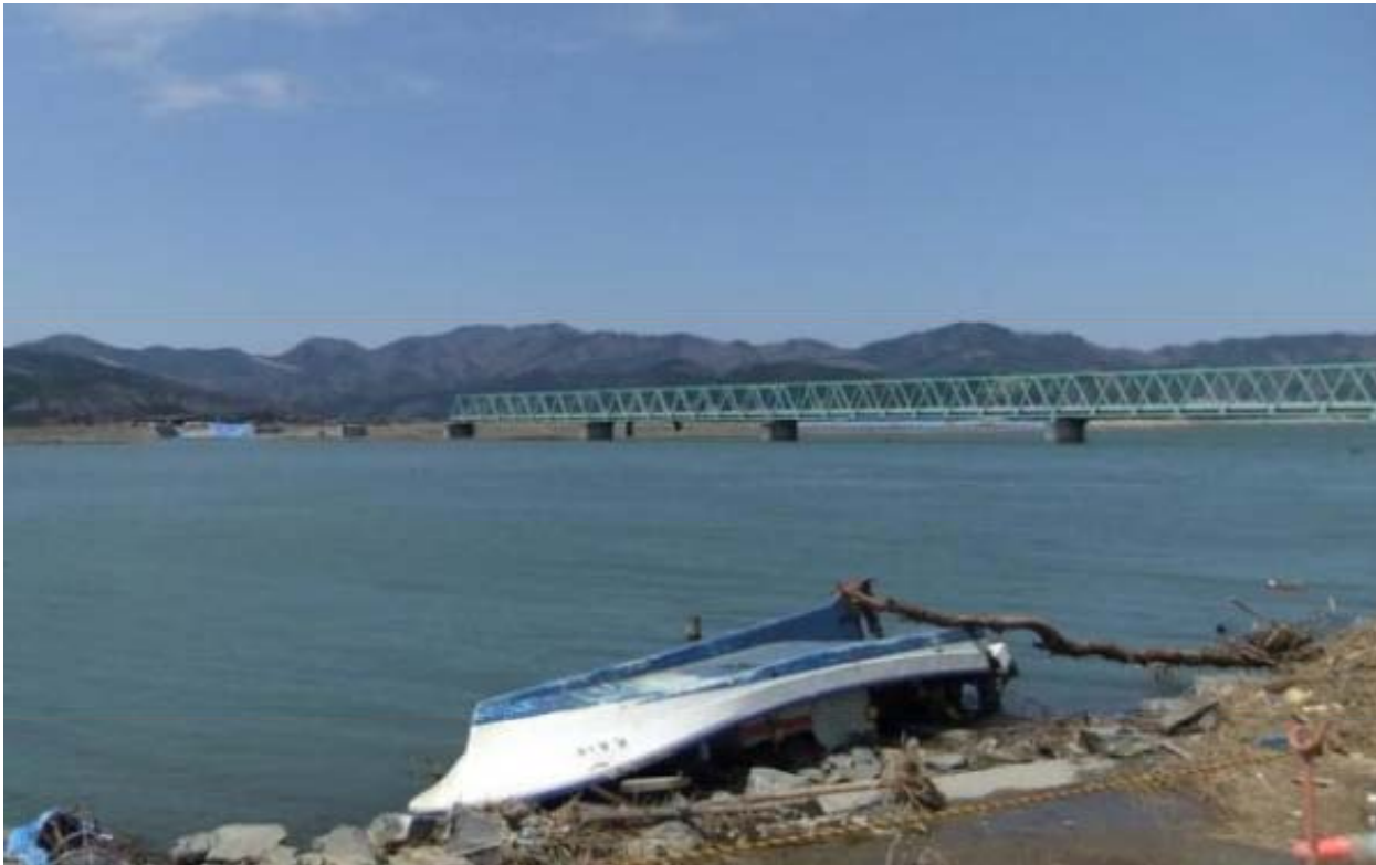
北上大橋 2スパン流失 (国道398号線) (3/27)
