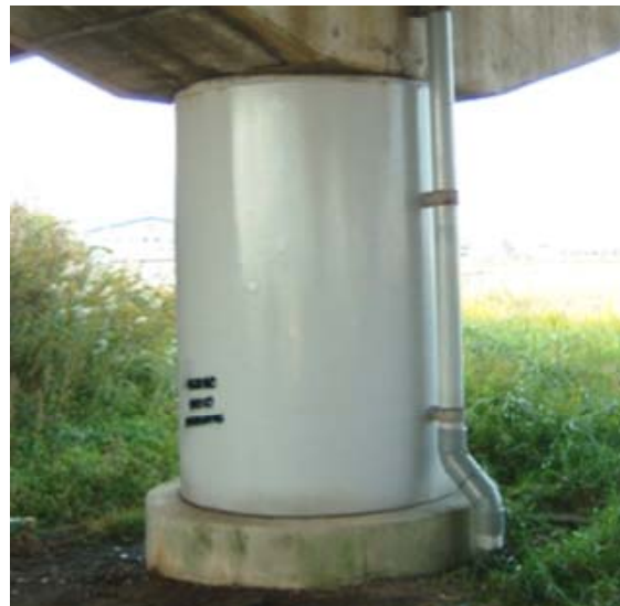
鋼板巻立て補強
