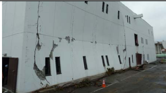
波圧や漂流物の衝突による外装材等の被害
