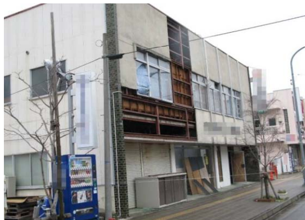
外装パネルの脱落
