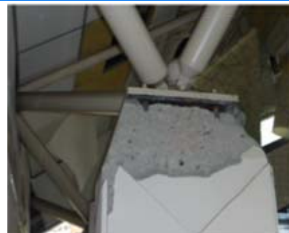
柱脚（支承部）コンクリート剥落
