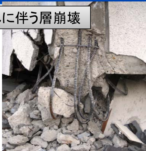
非構造壁のせん断破壊
