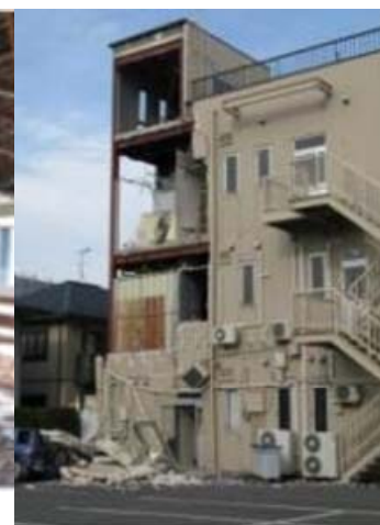
柱脚（支承部）コンクリート剥落
