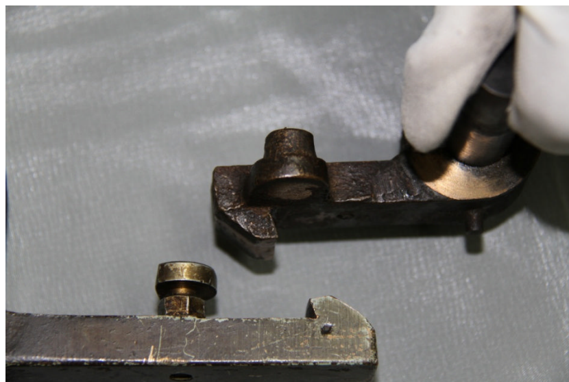
写真 6 1階乗り場戸の固定側及び移動側フック
