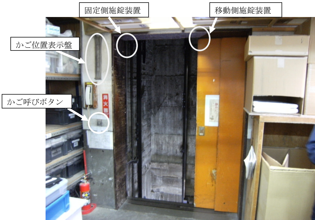
写真3 1階乗り場戸の状況
