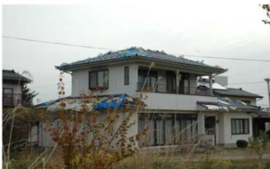
目立った棟瓦の損傷
