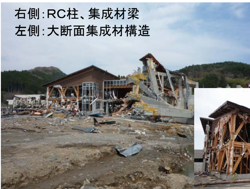
大断面集成材構造、外壁は破壊
