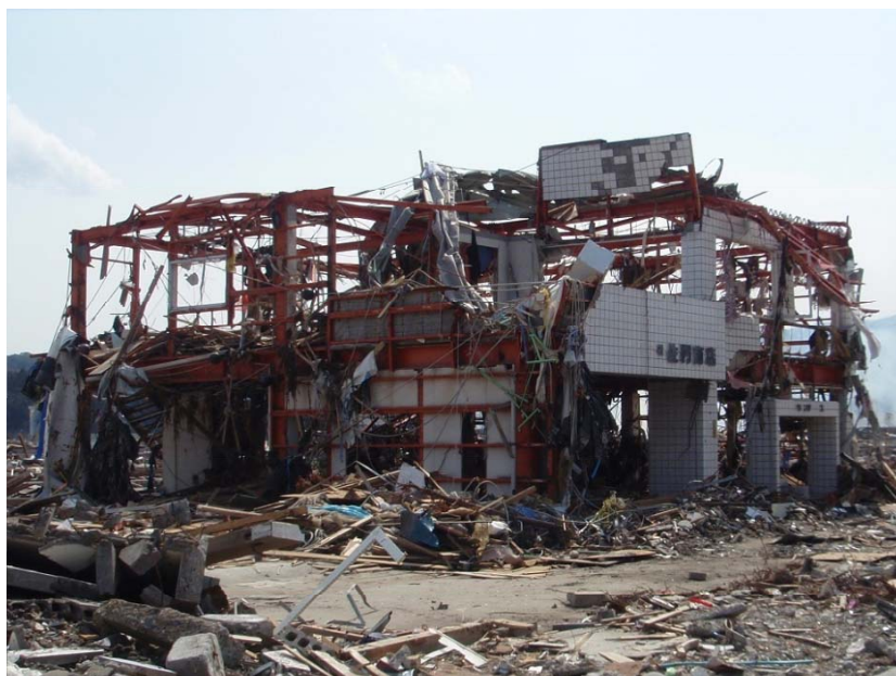
2階建てS造;骨組を残すのみ
