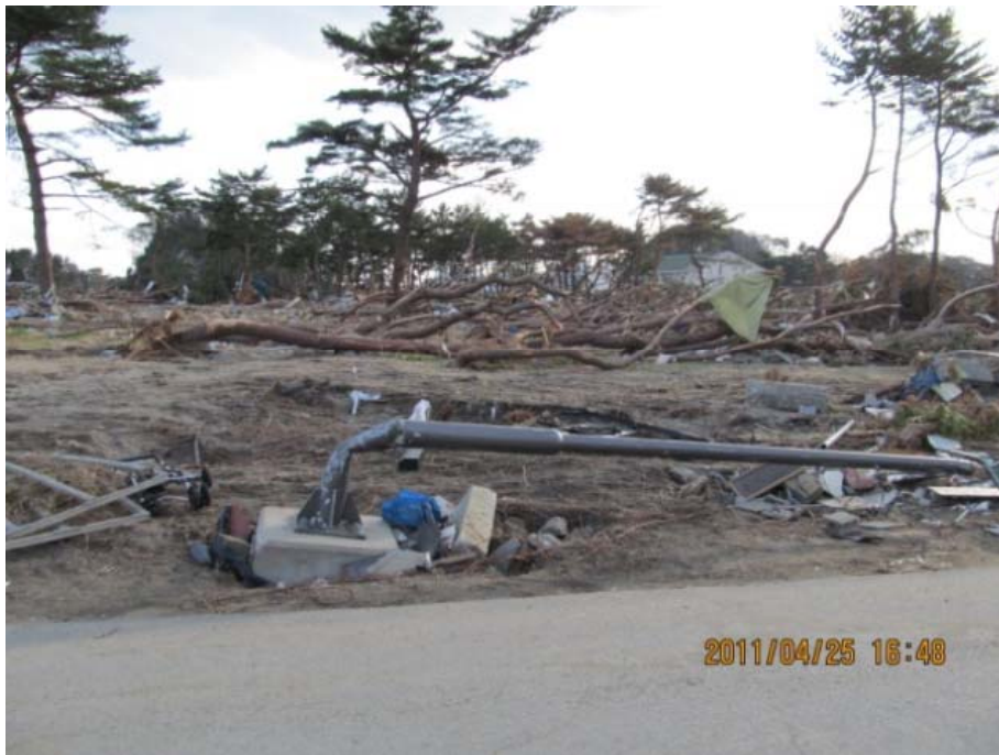
なぎ倒された防風林、街路灯
