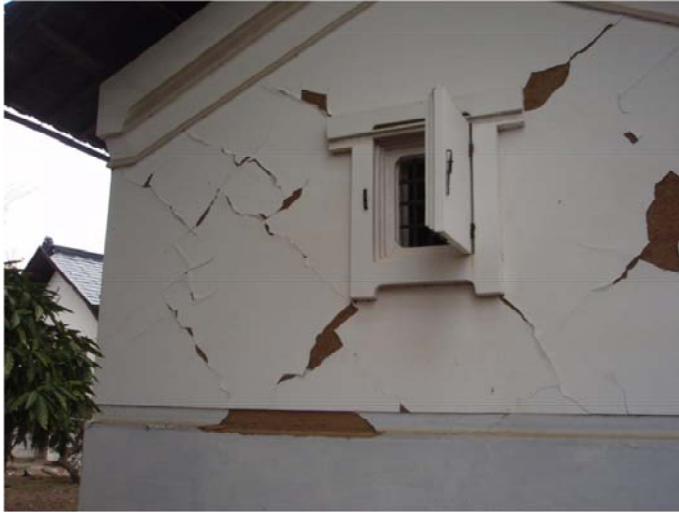
震動被害;土蔵の土壁の剥落
