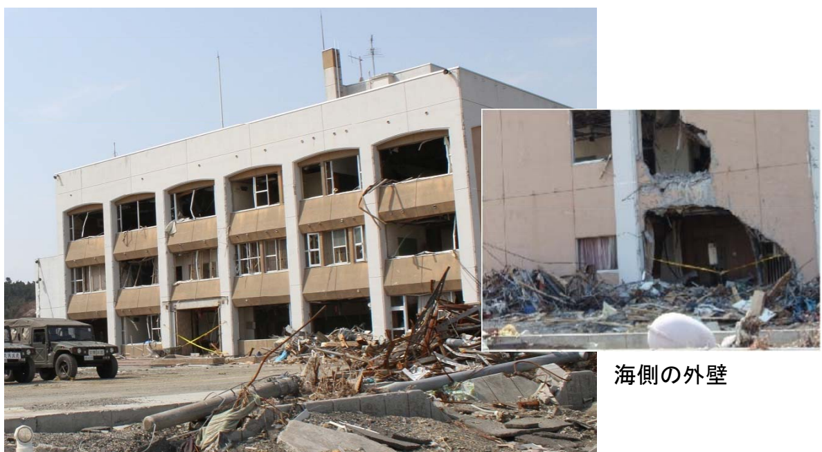
3階建てRC造；開口部が破られ、室内は壊滅状態
