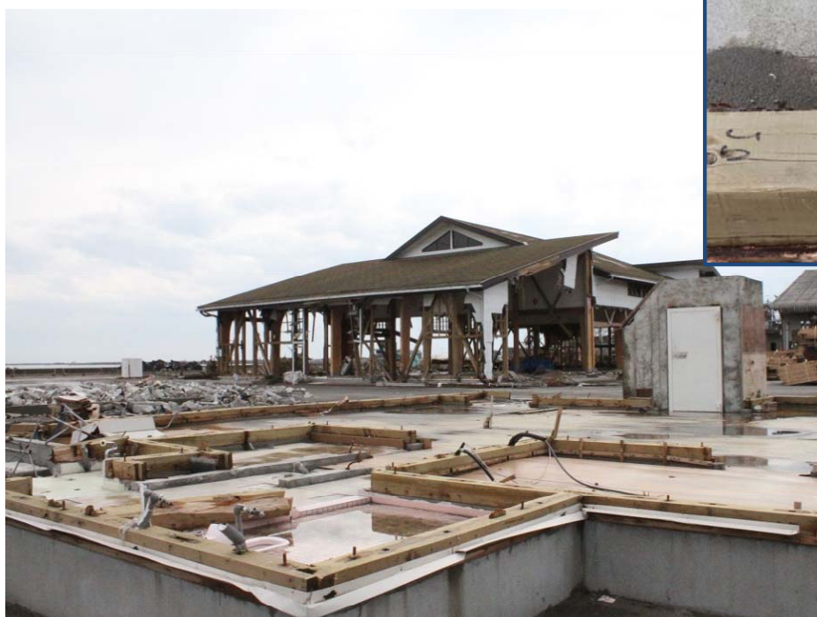
製材工場本社社屋；土台から上が流されている
