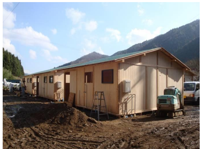
写真 2 岩手県住田町の木造応急仮設住宅
