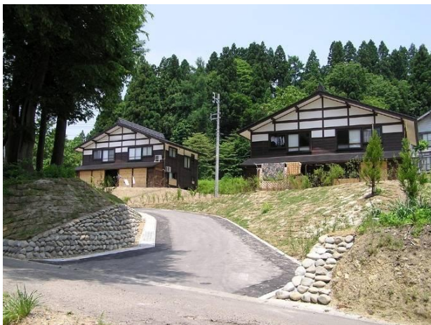
写真1 山古志における復興住宅の例 (桂谷団地・罹災者公営住宅)
