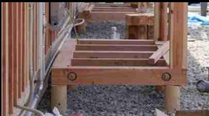
玄関ポーチの納まりは、建物と縁を切り、外壁の仕上などと、独立して施工することにより、ガス配管などの後工事に影響しないように工夫されました。
