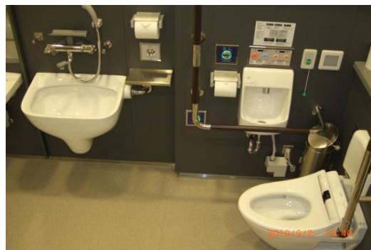
色々な利用者を想定した多機能トイレ
