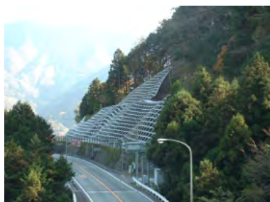
< 斜面崩落防止対策 >
