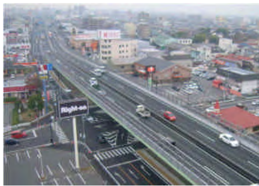
＜大気質対策（交差点立体化 [国道2号]）＞
