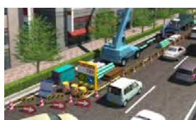
夏にガス工事
