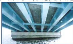
<塗装の塗替補修>
