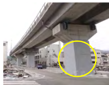
< 橋脚の耐震補強 >
