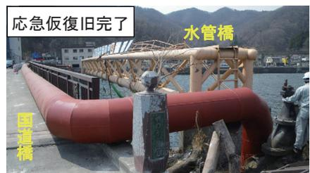
釜石市では東日本大震災の津波により処理場・ポンプ場計5箇所が被災したほか、幹線管渠においては流末近くに位置する矢の浦水管橋（全長 105m）が2/3ほど流失しました。
