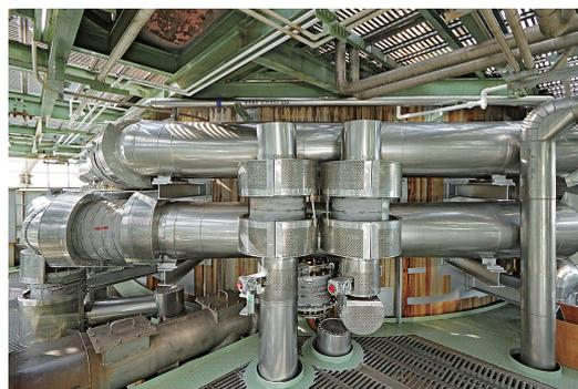
焼却炉上層に追加した空気を吹き込むダクト
