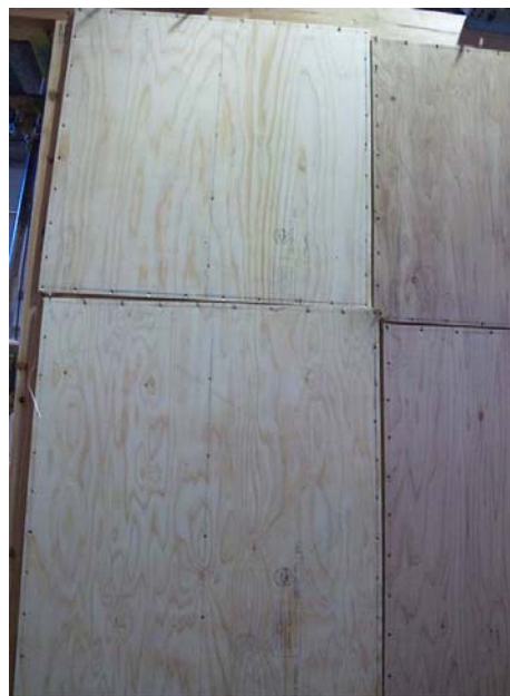
写真 2. 耐力壁の破壊形態
