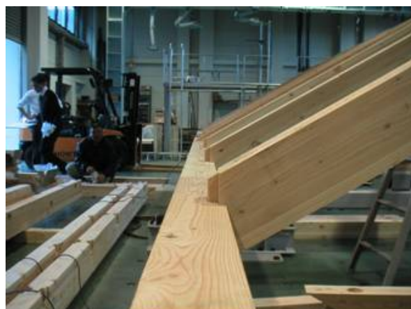
写真 4. 屋根構面の梁一桁接合部
