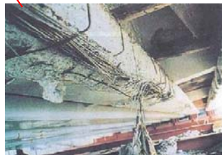
26年経過: 主桁PC鋼材の破断
