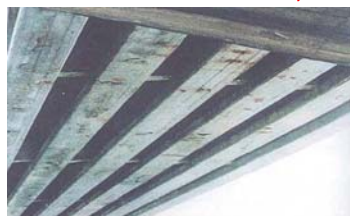
15年経過: 主桁下面にひびわれ、錆汁発生
