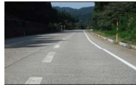
コンクリート舗装
