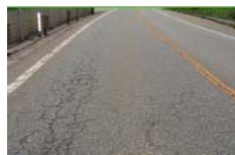
アスファルト舗装
