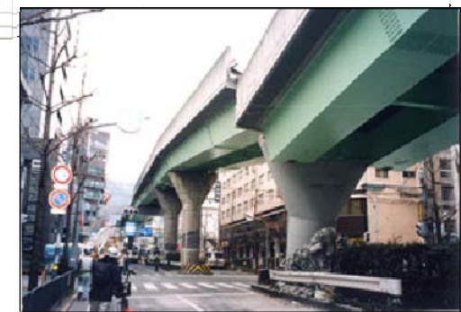
阪神・淡路大震災の被災状況
