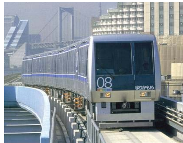
新交通システム Guideway Transit System
