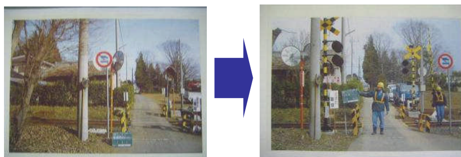
図1：踏切遮断機・警報機の整備
