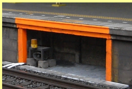
ホーム下の待避スペース
