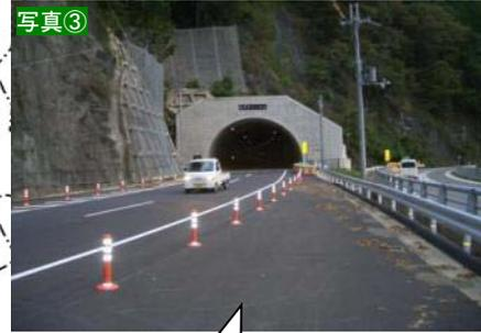
十津川道路(権限代行:H23.9一部開通)は、落石、土砂崩落等の実績をふまえ、長大切土を回避し、トンネル、橋梁を主体に計画
