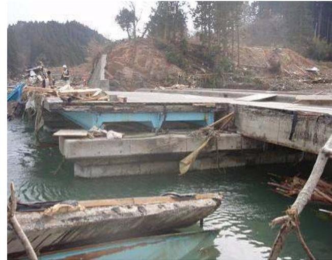
▲水尻橋(上部工及び橋台背面盛土流出)
