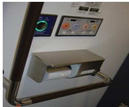
トイレの紙巻き機と洗浄ボタンの位置がJISに準拠しており、視覚障害者にも判別しやすい。
