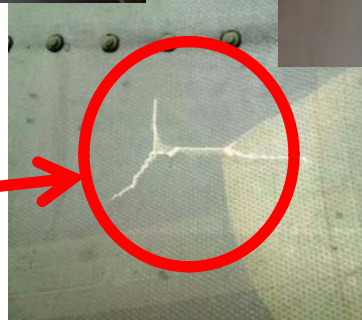
レドーム内側の亀裂
