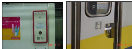
非常用通報器・運転室の施設
